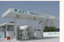
水素ステーション
