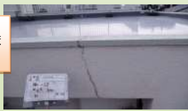
ひび割れと 緊急安全対策 の様子
