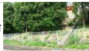
東名高速道路の法面状況
